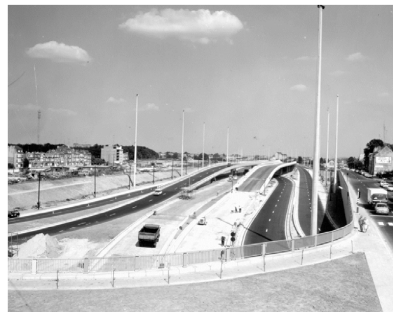
Figure 8 : Echangeur E40 en cours de finalisation
