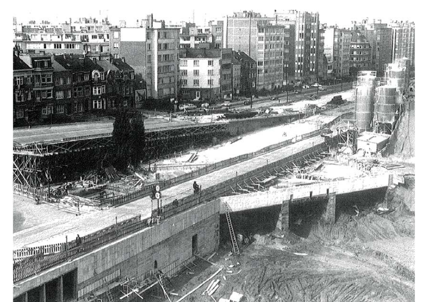
Figure 5 : Construction échangeurs E40 et rampe du viaduc Reyers
