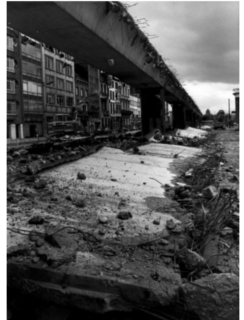
Figure 12 : viaduc Léopold II en cours de démolition
