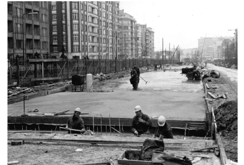
Figure 7 : Construction de la dalle du pré-métro
