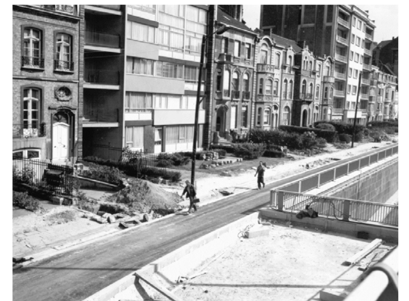
Figure 9 : Trémie en cours de finalisation
