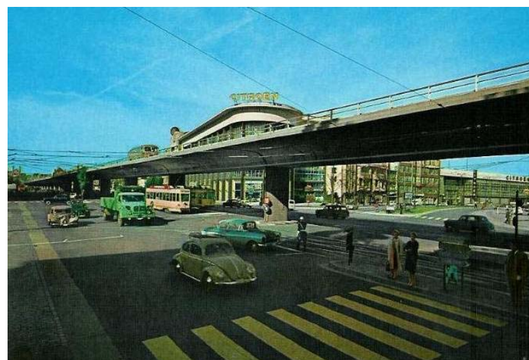
Figure 11 : viaduc Léopold II
