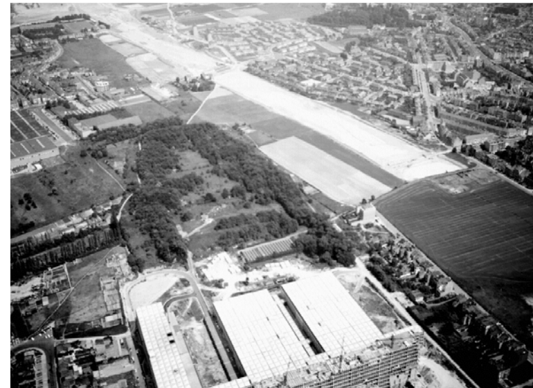
Figure 6 : Construction de la E40
